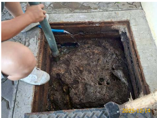
ภาพที่ 2-11 เจ้าหน้าที่สูบลำจัดตะกอนระบบบำบัดน้ำเสีย
