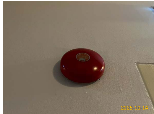
อุปกรณ์ส่งสัญญาณชนิดกระดิ่ง
