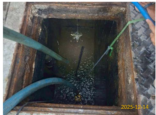
ภาพที่ 2-11 เจ้าหน้าที่สูบลำจัดตะกอนระบบบำบัดน้ำเสีย
